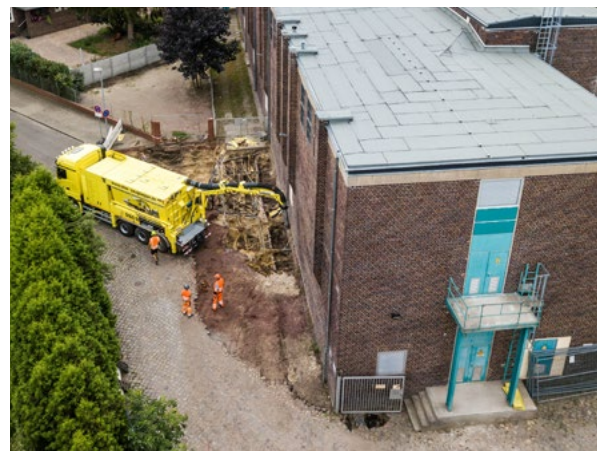
⌵ Freilegen von Leitungen mit einem Saugbagger am Umspannwerk Buckau
